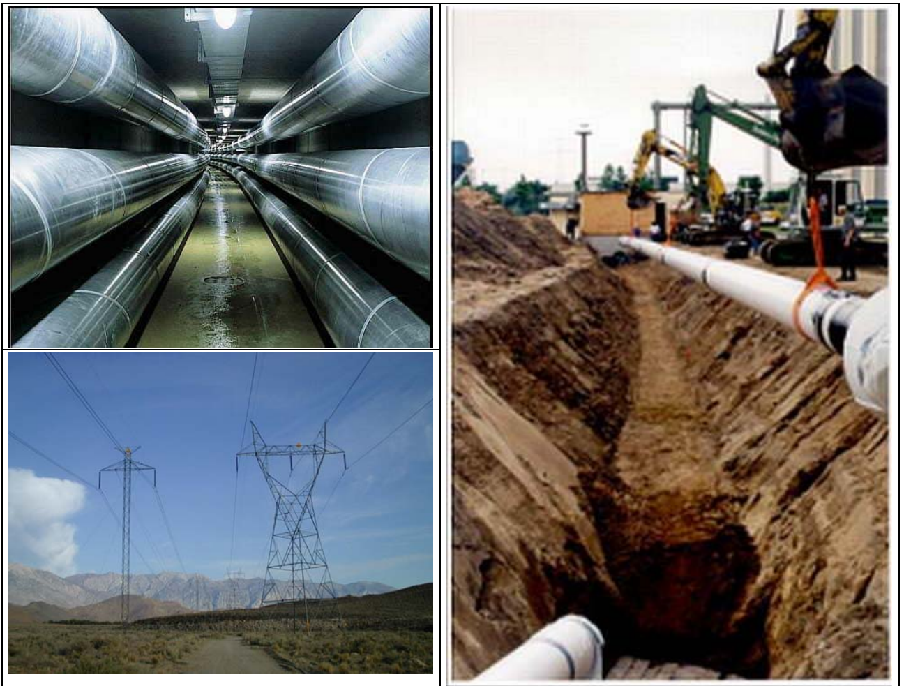
Figur 53 Unterirdische, gasisolierte Wechselstromleitung von Siemens, Palexpo-Gelände bei Genf, 220 kV
